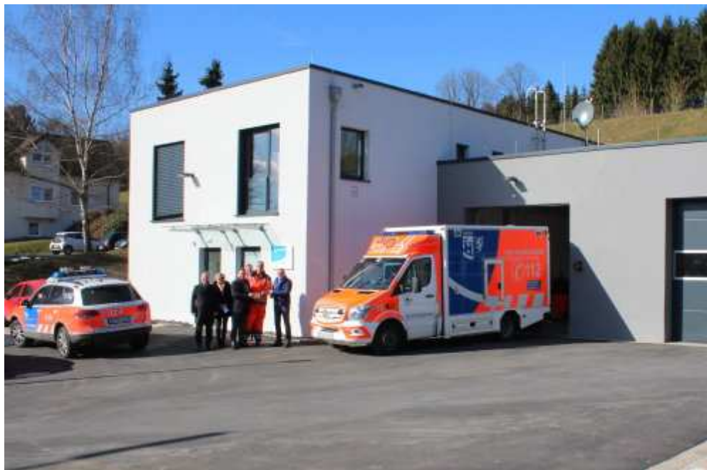
Die Rettungswache Wiehl befindet sich in der Bielsteiner Straße 2 in Wiehl-Kehlinghausen. (Foto: OBK)
